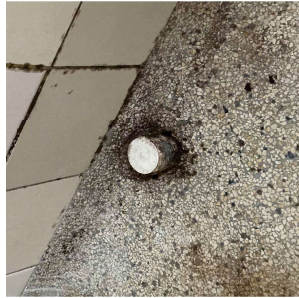
Rester fra tidligere rørføring fjernes
