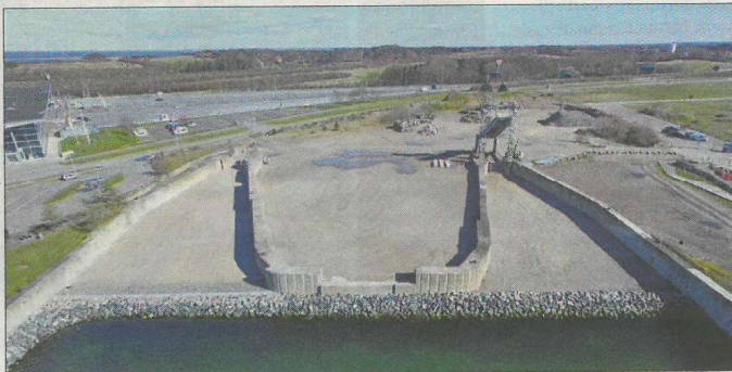
Når færgeløjet til højre er udgravet og M/F Broen skubbet baglæns med agterenden ind mod broklappen, vil den i første omgang se ud som »sunket«, fordi broklap og færgeløjet er bygget til færgen med to vogndæk. Efterfølgende bliver den hævet til 2,3 meter over daglig vande, så kommende stormfloder ikke kan nå den.
