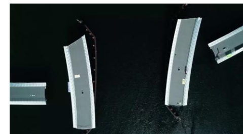
Lille Langebro (inspiration) Længde: 175 meter Bredde: 7 meter bred: 4 meter Højde: 5,4 meter på midten Vægt: ca. 600 tons i alt Pris: 12-16 mio. Euro
