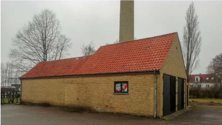
Den bevaringsværdige bygning set fra sydsiden
