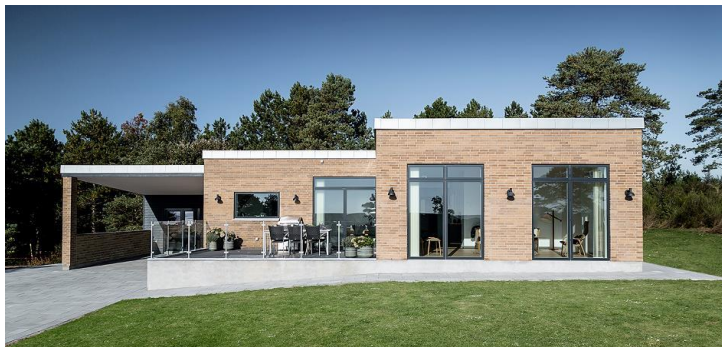
Eksempel på carport, som er opført i naturlig og arkitektonisk sammenhæng med hovedbygningen.
