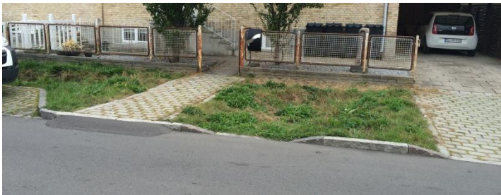
Her ses, hvordan der er lavet fordybninger i kantstenen, så vandet kan løbe ned i nedsivningsbæltet. Indkørselsarealet og gangarealet er udført i permeable belægninger, så regnvandet kan nedsive.
