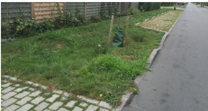
Eksempel på beplantet regnvandsgrøft langs vejen.
