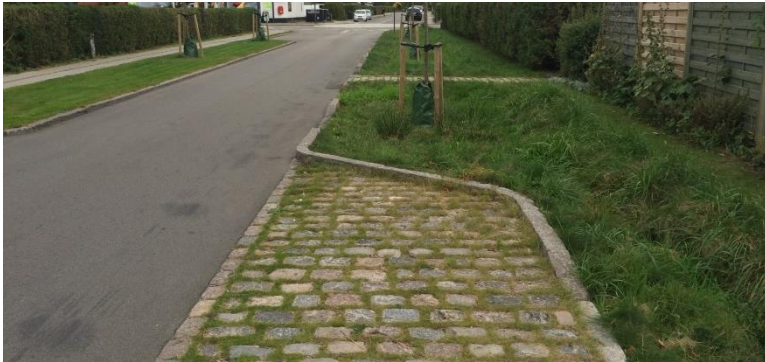
LAR-løsning med beplantet grøft og nedsvinings egnet parkeringslomme.
