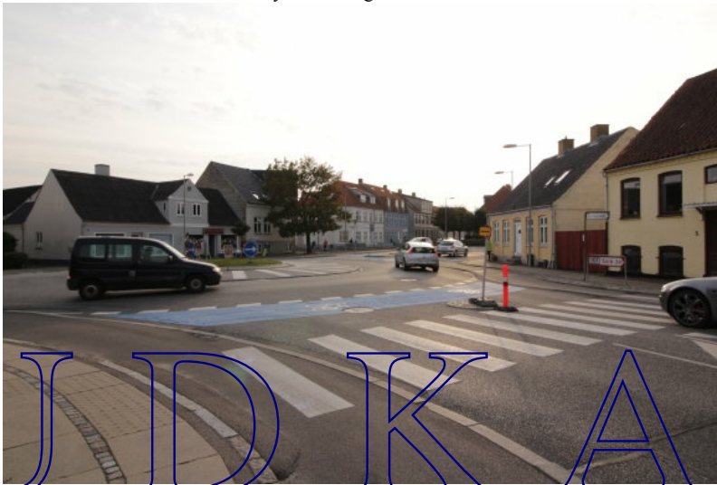
Rundkørslen set fra nordøst. Sorøvej er til højre.
