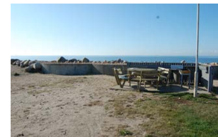
C Betonelementer ved overgangen til stranden syd for havnen
