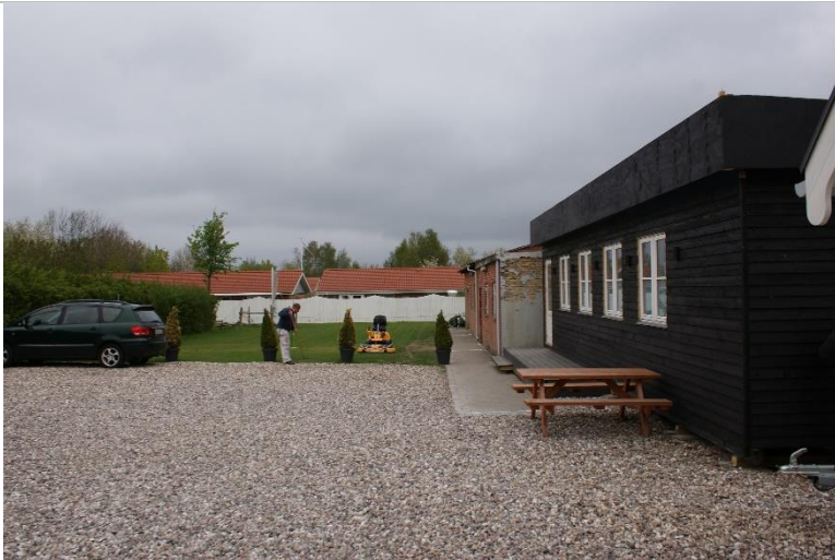
På billedet ses den midlertidige pavillon fra 2017 og den ældre erhvervsbygning fra 1927, som er placeret længst tilbage på grunden. Desuden viser billedet eksisterende parkering og legeplads.
