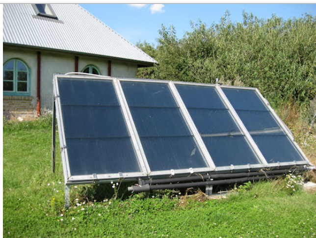
Solceller og solfangere behøver ikke at sidde højt på et tag. Det kan som her stå på jorden eller på et udhugstak.
