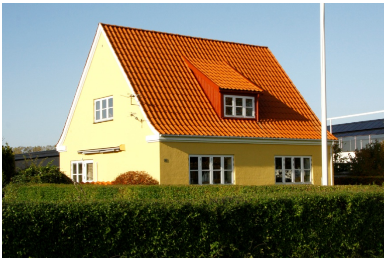
Et fint, enkelt eksempel på en udbredt hhustype, der også er bevaringsværdigt. Tagets møde med facader er uden udhæng – et eksempel til efterfølgelse.
