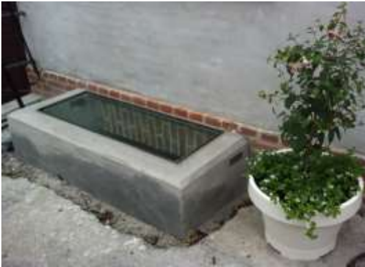
Lyskasse med skybrudssikring og glas
