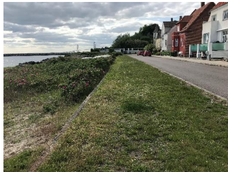
1. Græsribat afgrænset med betonekant mod strand langs Strandvej (84 bf) mod vendeplads.
