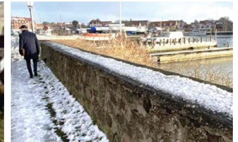
Den eksisterende mur langs Kajgade. Foto: Schönherr
