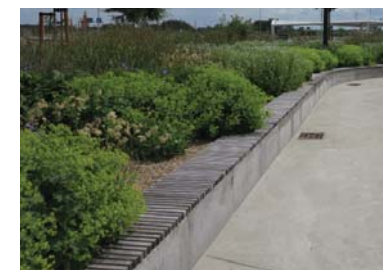
Kant med træbeklædning, Schönherr
