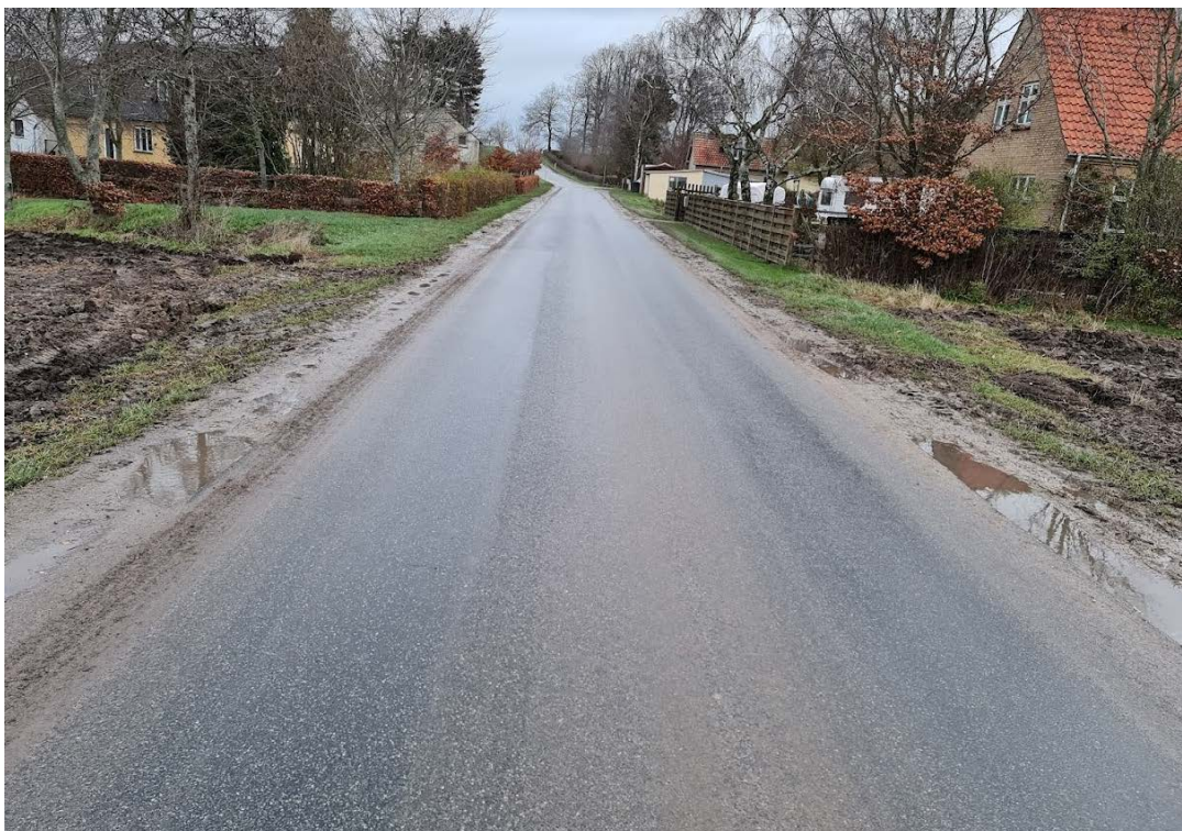
Gimlingevej ved Fodsporet. Ca. 3,8 meter bred
