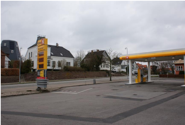
Tankanlægget i lokalplanområdet
