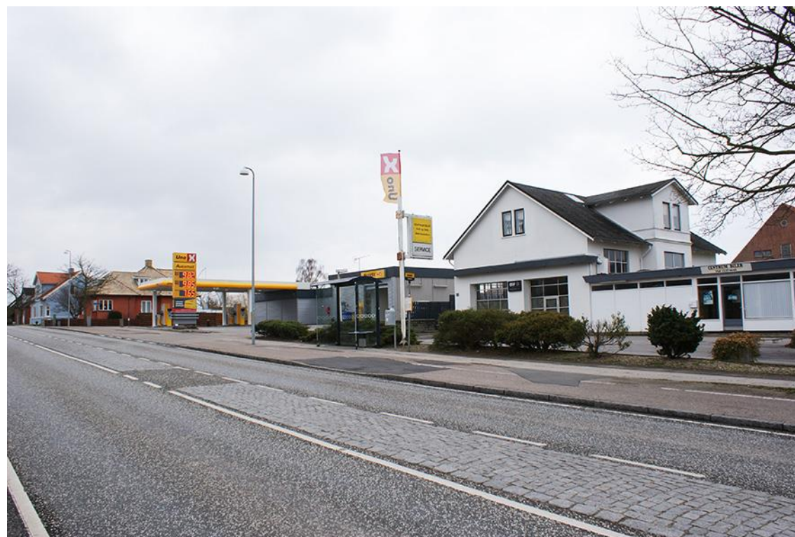
Eksisterende bebyggelse i lokalplanområdet set fra Skovvej.
