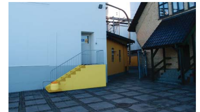
NEDRIVNINGSSOMRÅDE AF TRAPPE TIL PRODUKTIONSHAL
