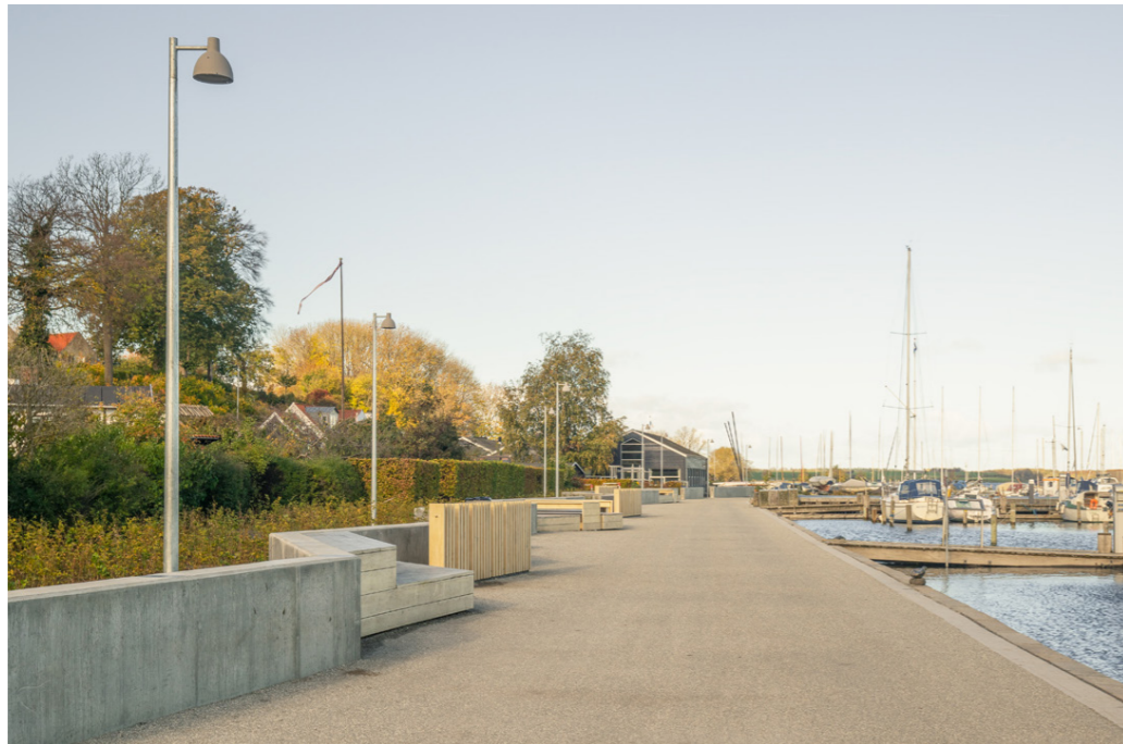
Opholdslommer langs højvandssikring, Kystsikring Roskilde, Cornelius Vöge
