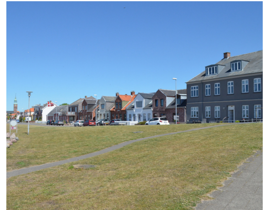
Højt terræn hvor højvandssikring afsluttes ved Sylowsvej
