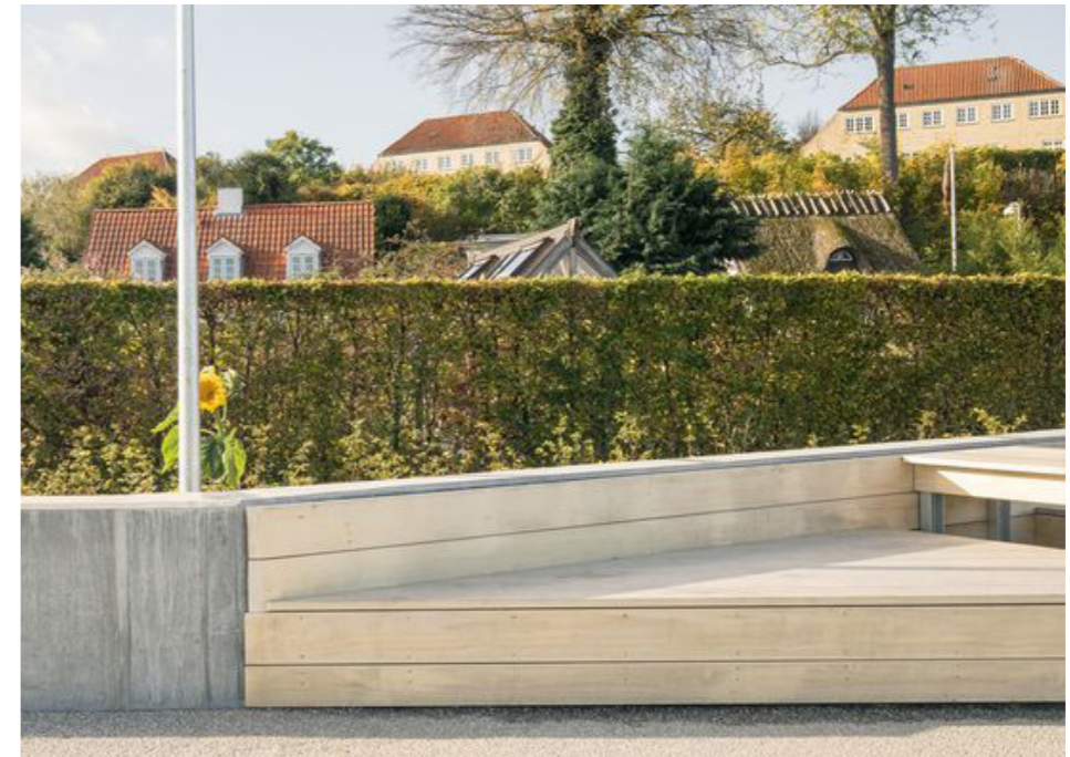
Opholdslommer langs højvandssikring, Kystsikring Roskilde, Cornelius Vöge
