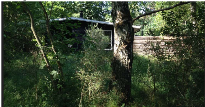
Et sommerhus på Solsikkevej har opsat et vandret raftehegn foran sin terrasse.
