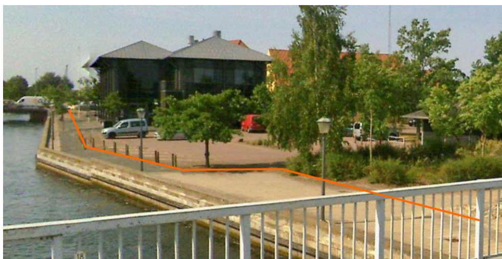
Figur 6-7 Placering af L-elementer, strækning F-G
