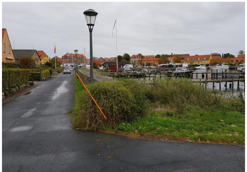
Figur 6-10 Placering af renoveret betonmur langs, strækning E-F
