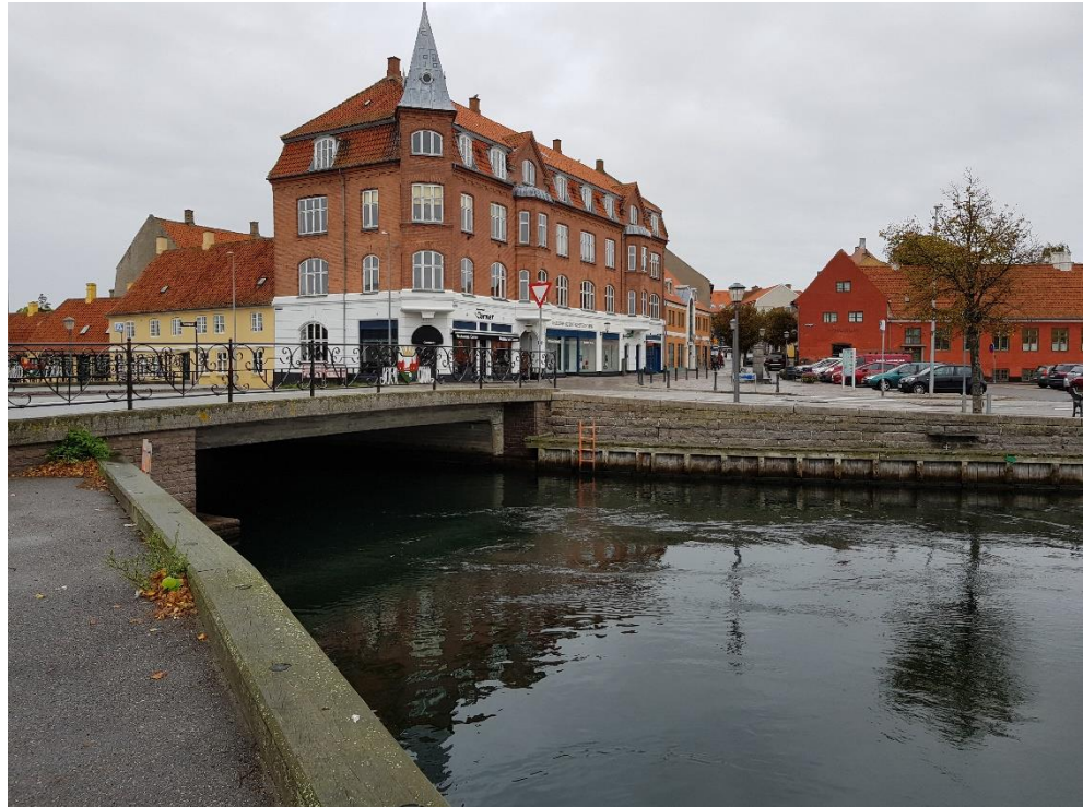
Figur 2-5 Den flotte bro hvor Vestergade krydser kanalforbindelsen mellem havnen og Noret. Broen med smedjernsrækværket med købstadens våben er fra 1906 og er efterfølgende gjort tidssvarende i bredden i 1958.
