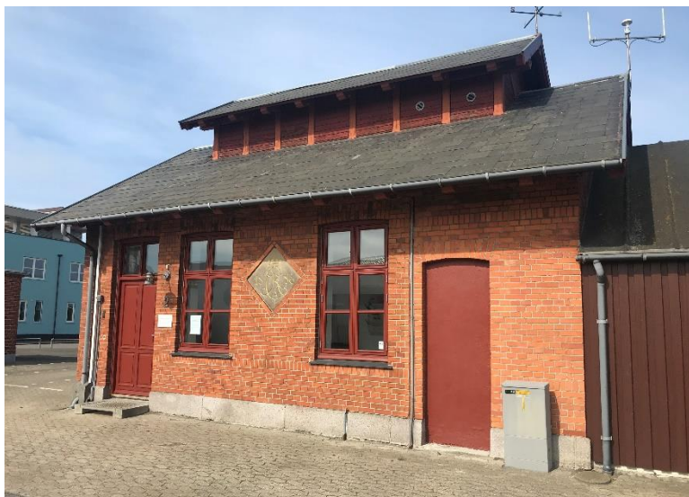
Bygning A. Facade mod syd.
