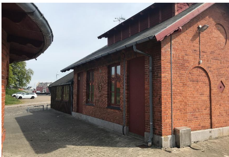
Bygning A. Gavl mod vest og facade mod nord.
