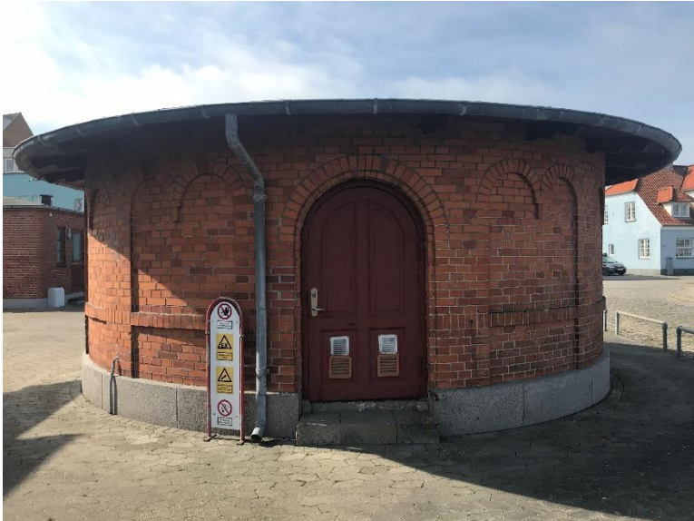
Bygning C. Indgangsdør mod øst.
