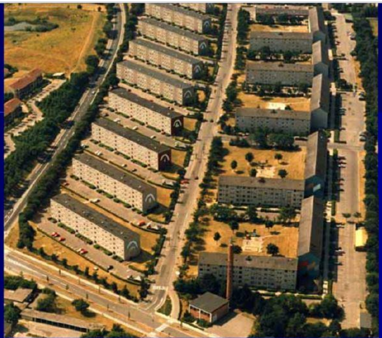
Boligområdet Ringparken beliggende i den nordlige udkant af Slagelse. Består af 732 boliglejemål og 6 erhvervslejemål heraf 2 børneinstitutioner. (Området før renovering)
