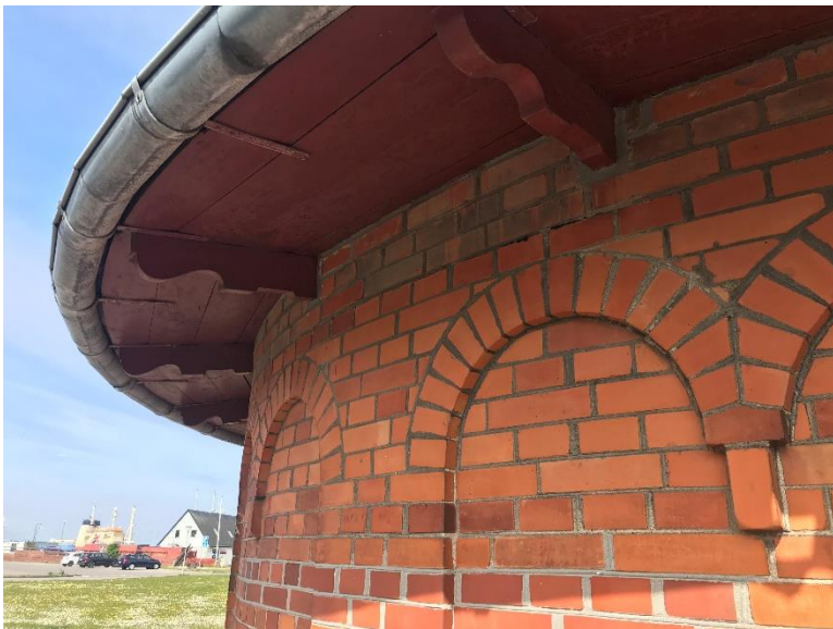
Bygning C. Udhæng med udskårne spærender.
