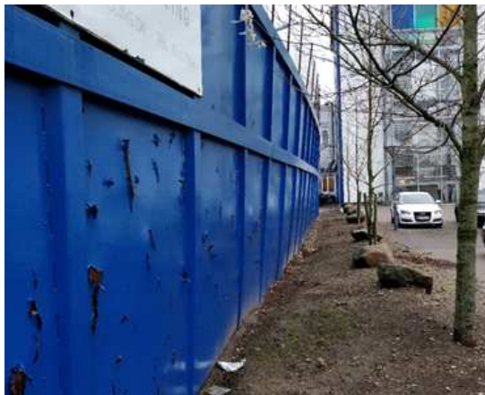
Grøn bevækstning må fjernes for at gøre plads til støjmur.
