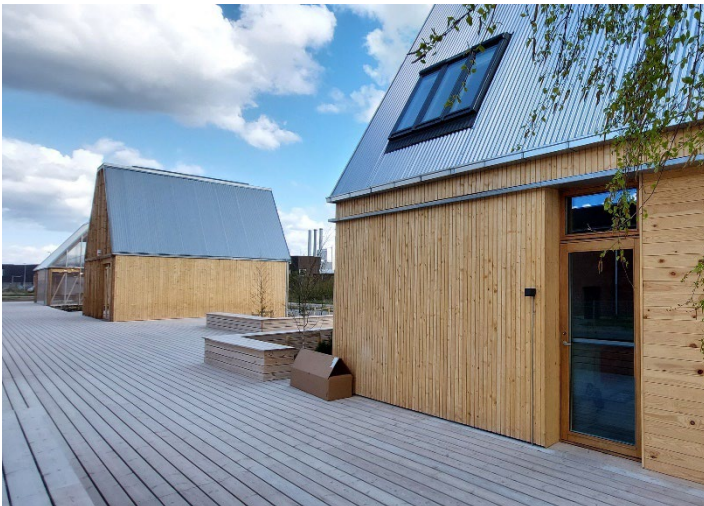
Foto af hævede stier i træ, som både er adgangsgivende til boligerne og som skaber mulighed for ophold omkring boligerne.
