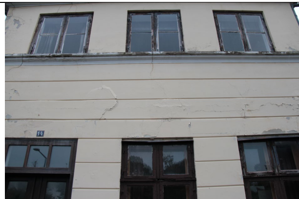
Fleres sætningskader i frontspids
