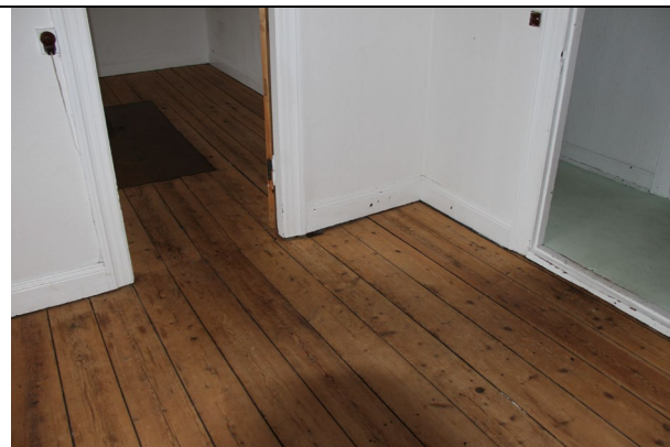
Opklodsning af karm grundet nedbøjning i bjælkelag
