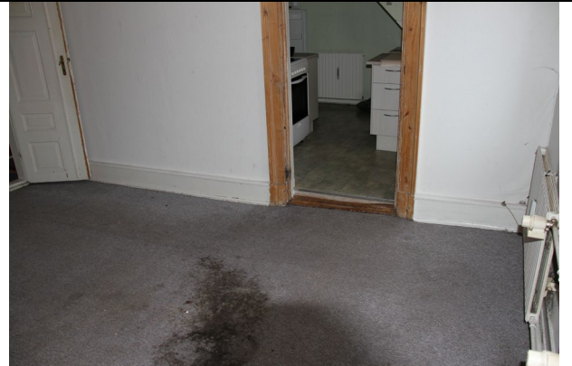
Opretning af gulv og synlig nedbøjning i bjælkelag
