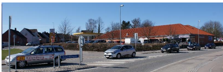
Forbindelsesvejen mellem Kalundborgvej og Valbygårdsvej.
