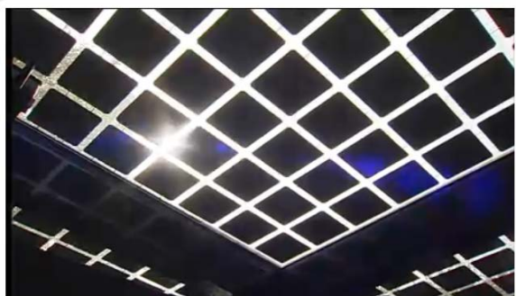
Eksempel på solceller lagt som diskret overdækket terrasse, med næsten vandret tagflade.
