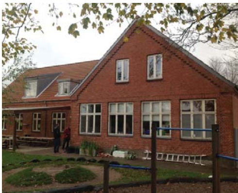
Vestgavl og facade med kviste i taget beklædt med zink, samt ny overdækning
