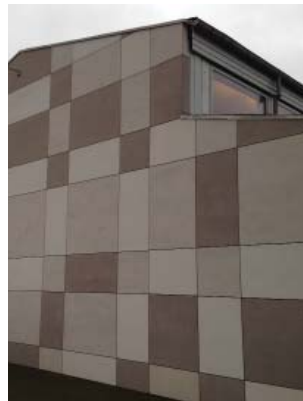
Efterisolering af nordlig gavl, Mellemlinnet
