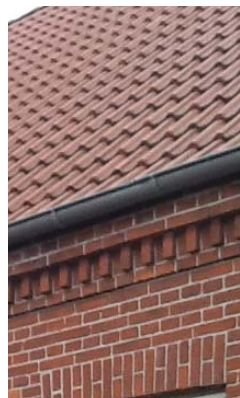
Smukke detaljer i murværket
