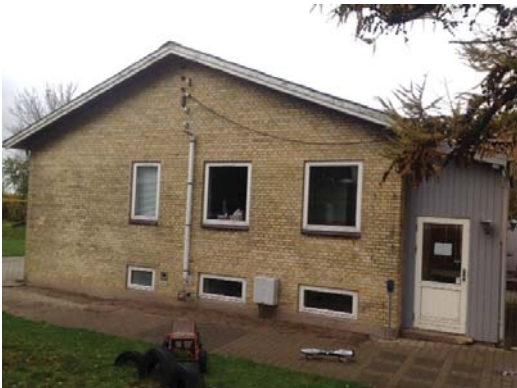
Børnene ankommer via en dør i tilbygningen som fører til en garderobe i kælderen. (Østvendt gavl)
