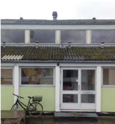
Ankomst hovedbygningen. Opbygning med sandwichelementer ses tydeligt.
