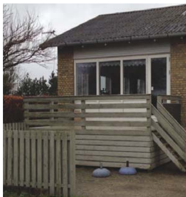
"Påklitstrede" tilbygninger (terasse i forgrunden)
