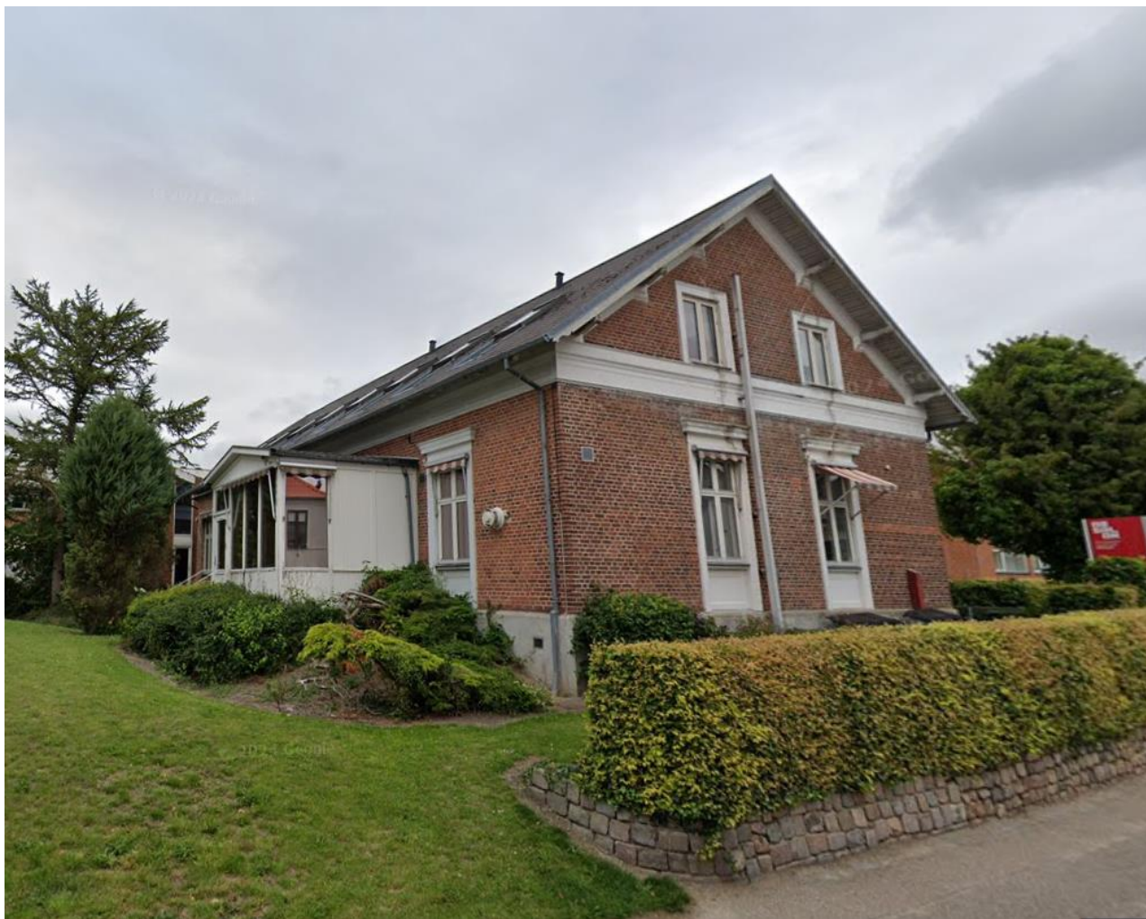
Google streetview, juli 2020. Bryggeriets administrationsbygning, der er vurderet til SAVE 4 planlægges nedrevet. Bemærk murværkets krydsforbandt som giver en fin og enkel dekoration. Det nyere tag har for stort udhæng og karnappen er dårligt tilpasset. Begge dele er reversible.
