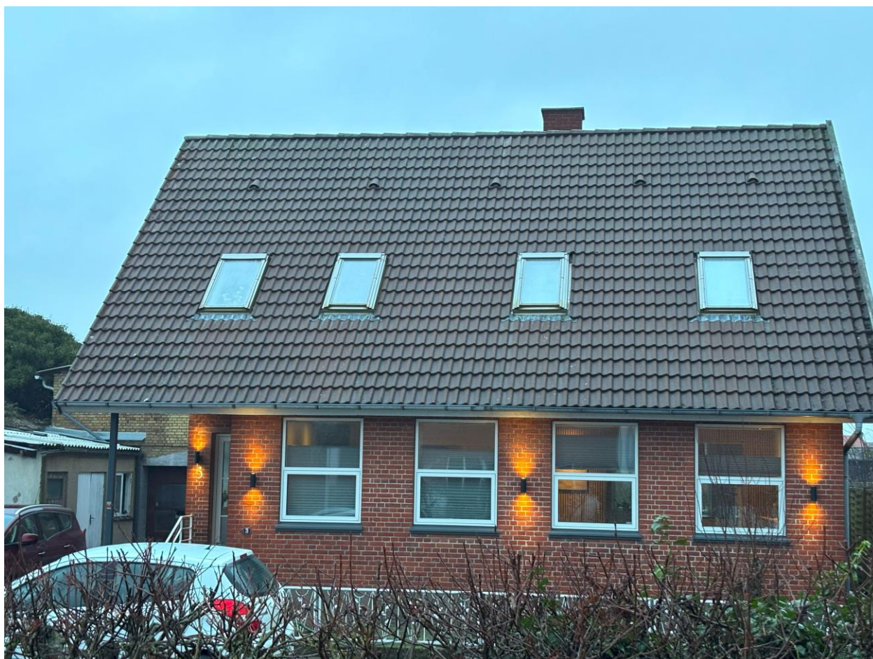
2. Vores ejendom Parkvænget 3, set fra auditoriet i stueplan. Tag vinduer vender direkte mod byggeriet.
