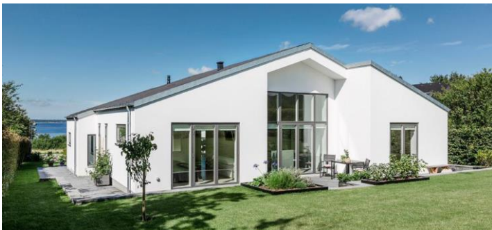
Eksempel på saddeltag, hvor taghældningen er ca. 30 grader. Fotokilde: www.skanlux.dk
