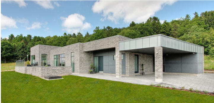
Eksempel på anvendelse af forskellige materialer i facadeudtrykket.
