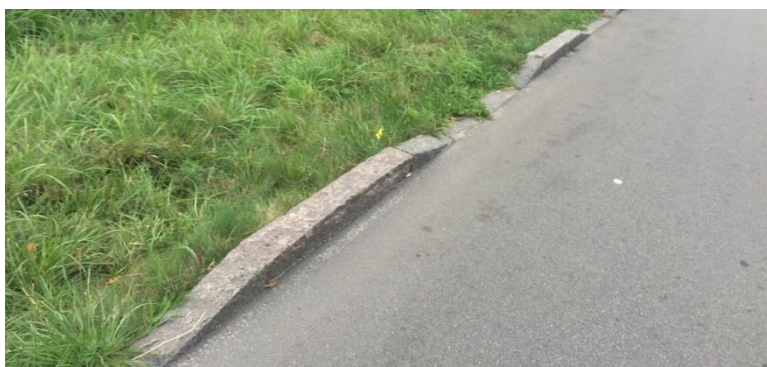
Fordybninger i kantstenen, så regnvand fra vejarealet kan nedrive.
