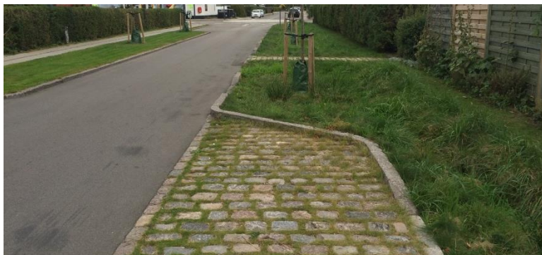
LAR-løsning med beplantet grøft og nedsviningsegnet parkeringslomme.
