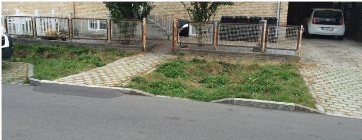
Her ses, hvordan der er lavet fordybninger i kantstenen, så vandet kan løbe ned i nedsvinningsbæltet. Indkørselsarealet og gangarealet er udført i permeable belægninger, så regnvandet kan nedsive.
