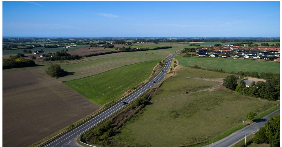
Et kig mod nord langs Skælskør Landevej. Slots Bjergby ses til højre.
