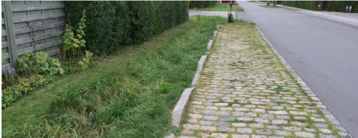
Her ses den beplantede grøft sammen med en parkeringslomme i permeabel belægning (brosten).
