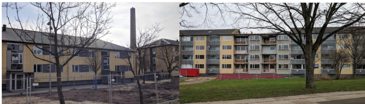
Illustration: Blokke på fire etager er nu omdannet til hhv.to og tre etager. I forgrunden skal det nye grønne byrum anlægges, som erstatning for en parkeringsplads (t.v.). Den lange nord/sydgående blok bliver netop nu punktvist nedrevet to steder (t.h.)
