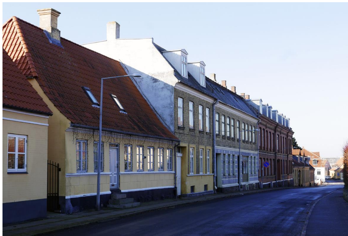
Facaderække i Algades østlige ende.
