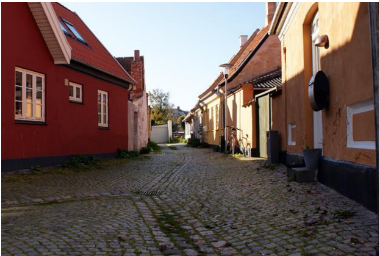
Brolægning i Rosenstræde. Særligt karakteristisk er her bevaringen af vandrenden/rendestenen i midten af gaden.
