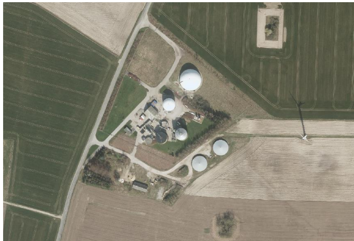
Biogasanlægget som det ser ud i dag (luftfoto 2019).
