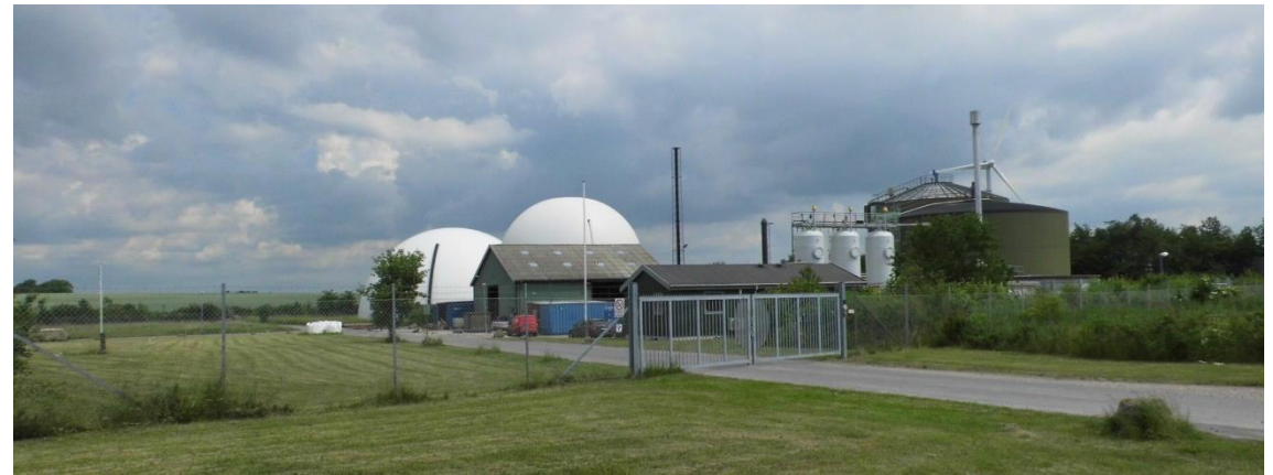
Nuværende anlæg set fra Vemmeløsevej ved den sydlige port i retningen mod nordøst.
