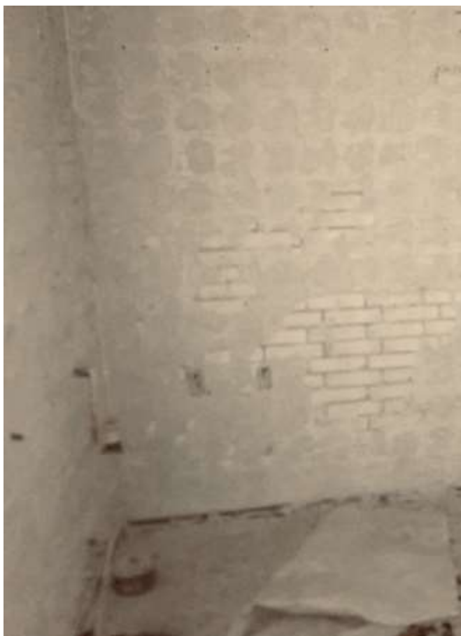
#7 Kælder. Vådrum med klinker på gulv
