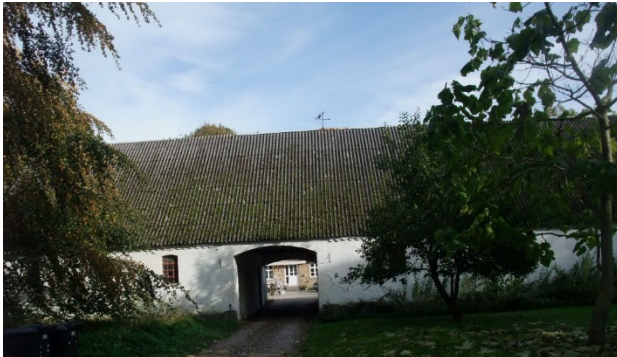
Pilevangsgaard vestlænge, tidligere staldbygning
