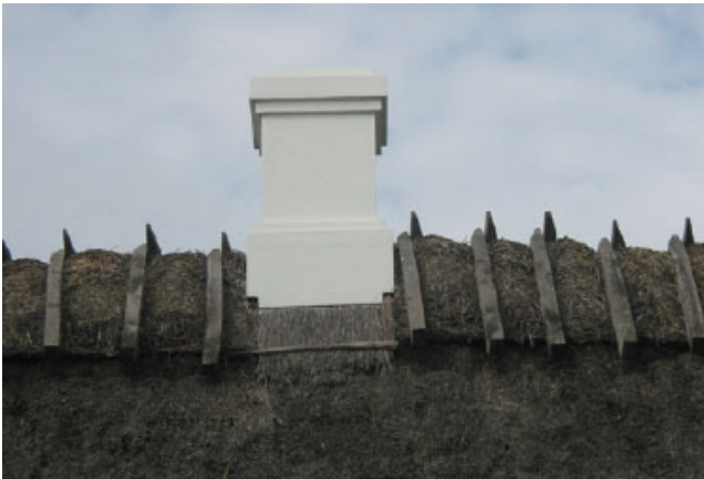
Eksempel på skorsten i en stråttækt ejendom
