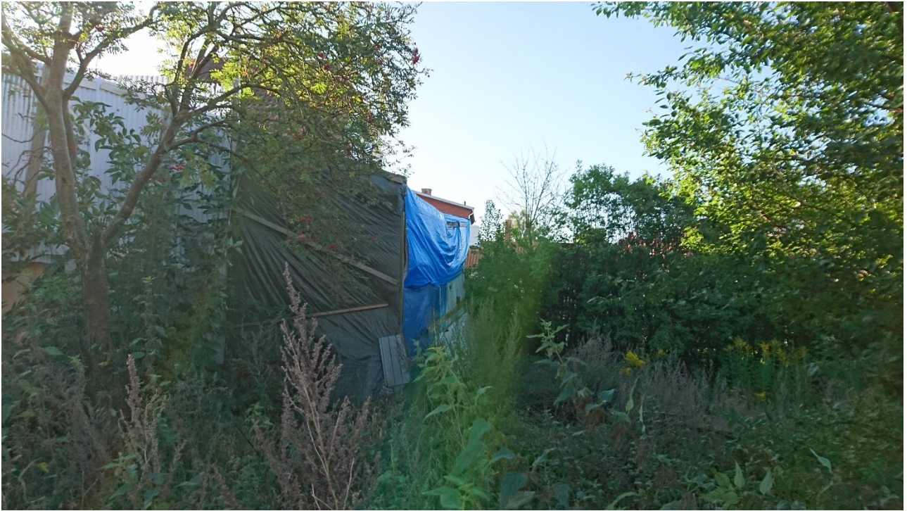
Haven og bagside af bygningen.
