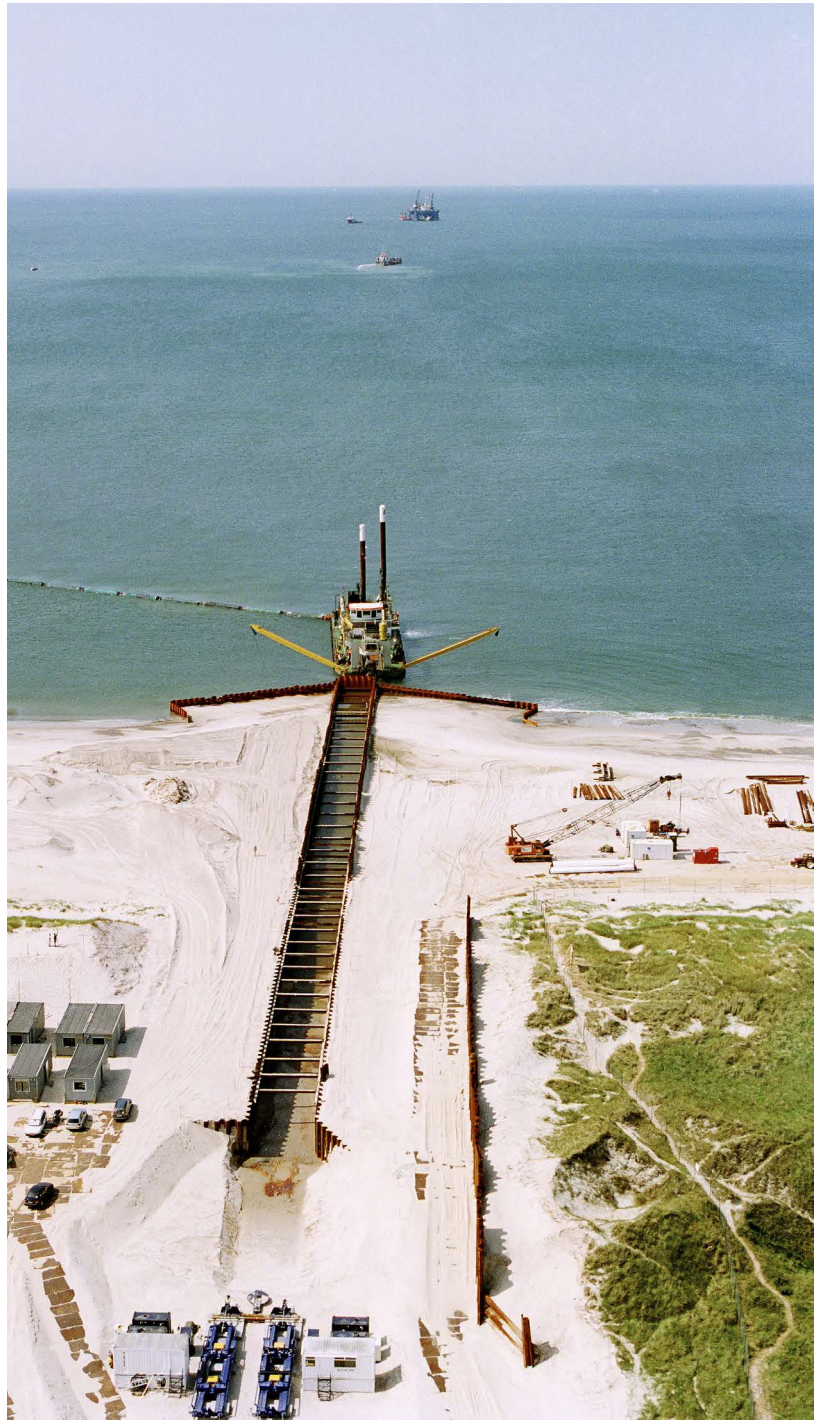
Spunset ledningsgrav, hvor gasrørledningen ilandføres ved kysten
