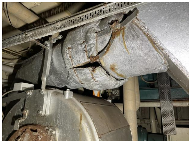
#14 Maskinrum, groft lærred og kiselgur omkring udstødningsmanifold fra kedel
