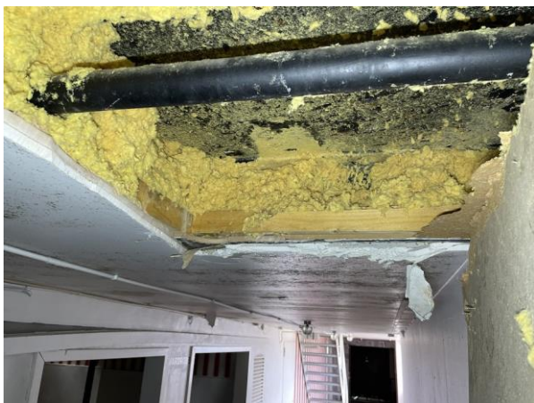
#19 Promenadedæk, Nedsænket loft med mineraluldsgranulat
