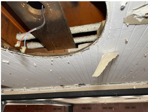
#15 Promenadedæk, rør med umalet groft lærred over nedhængt loft
