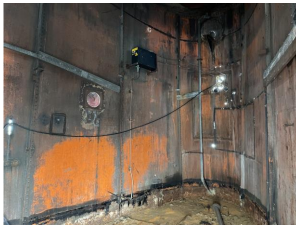
#22 Bådedæk, skorsten indvendigt
