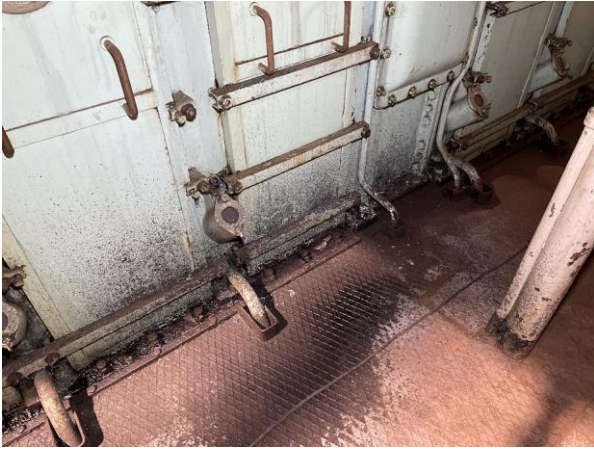
#7 Maskinrum, olievædning af maskindele og gulv
