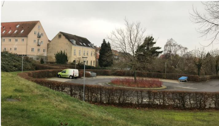
Anlagt parkeringsareal i forlængelse af Nytorv
