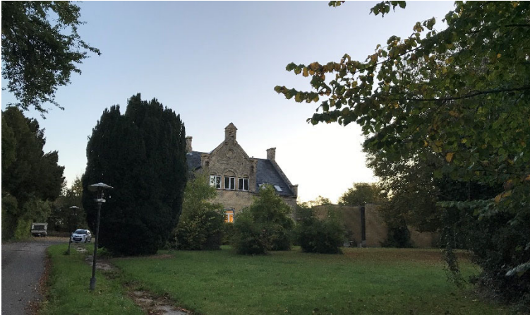
Skælskør tidligere bibliotek er i dag indrettet med flere lejligheder. Bygningen og dens baghus har høj bevaringsværdi.
