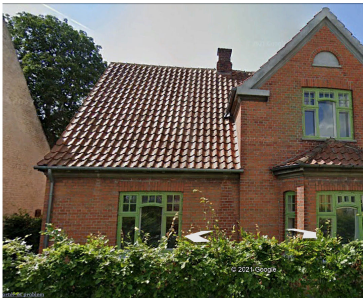
Havnevej 67 er et fint eksempel på et hus der har bevaret de gamle vinduer.
