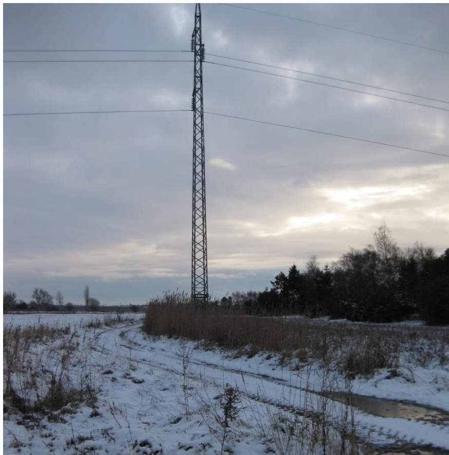
Figur 2.17 Mast 7 tilhørende SEAS-NVE
