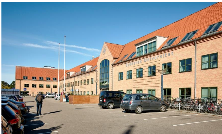
Perron 1-bygningens facade mod Sdr. Stationsvej.
