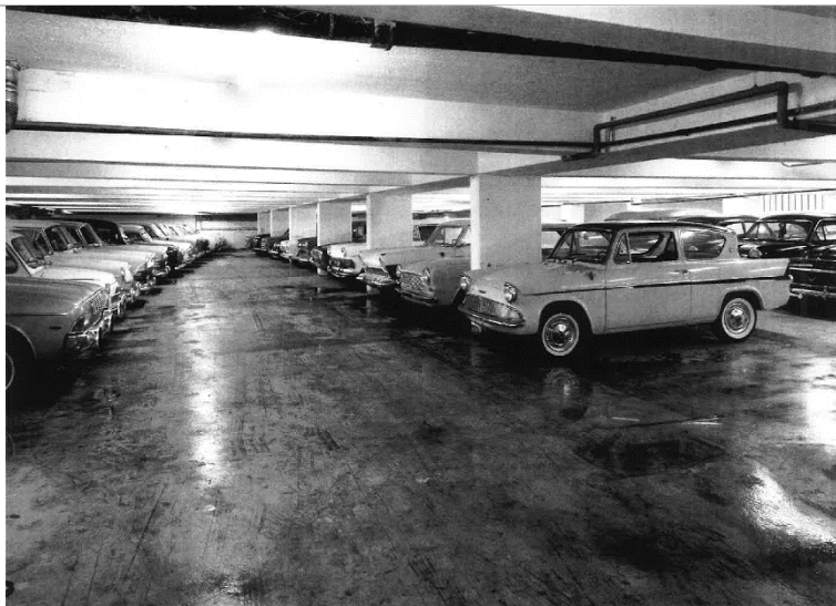
Eksisterende parkeringskælder som bevares.
