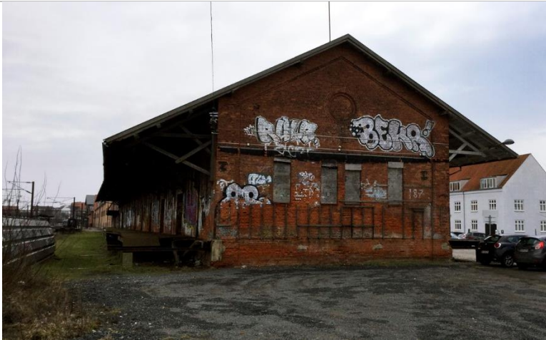
Godsbanebygningens vestgavl som den står i dag.
