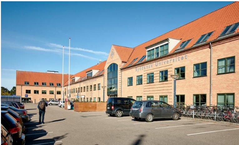
Perron 1-bygningens facade mod Sdr. Stationsvej.
