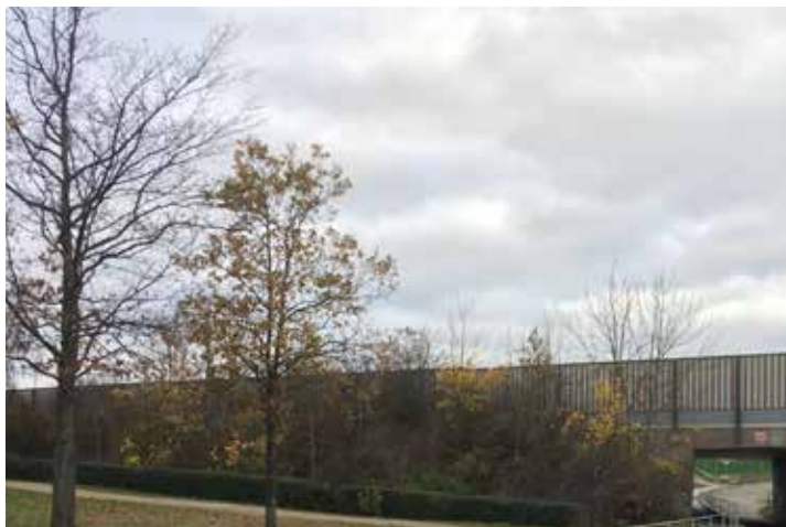
Støjtavler og tunnel under Vestmotorvejen
