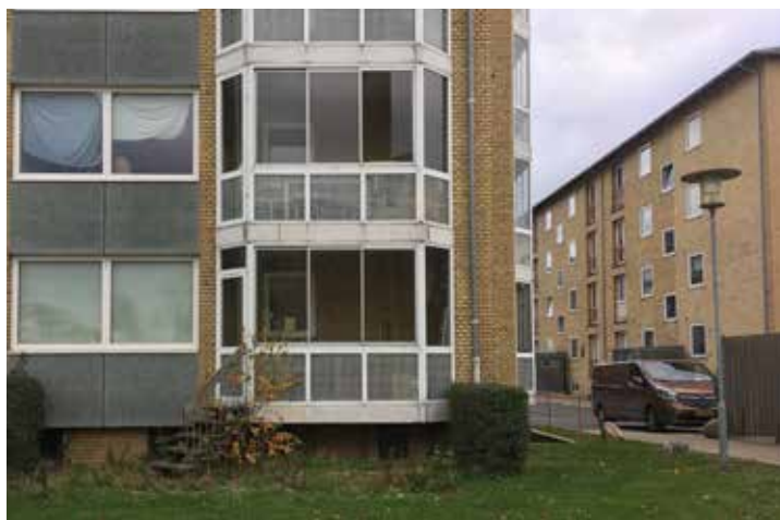
Forareal med trappe ned til terræn, Afd. 35
