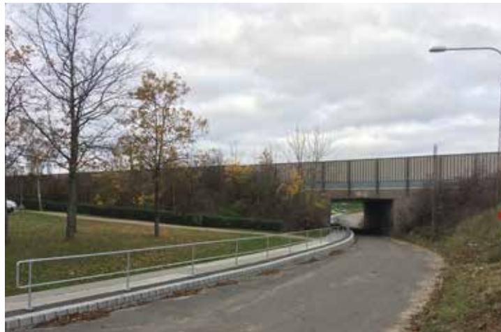
Tunnel under Vestmotorvejen
