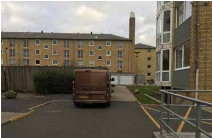
Begrænset udsyn på grund af hegn og garager, Afd. 35
