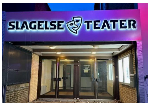
Nyt facadeskilt mod Herrestræde er etableret i samarbejde med brugerrådet under Vestsjællands Teaterkreds som forpagter.
