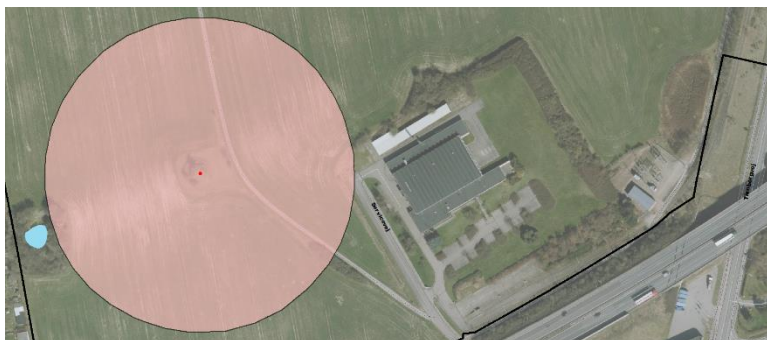
Mod syd: Beskyttet fortidsminde og beskyttet sø. Nord for transformerstationen, ligger et potentielt naturområde.
