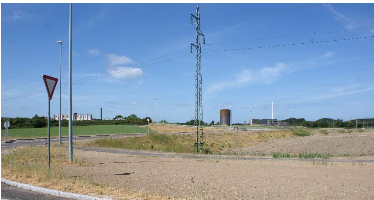
Eksisterende 50 KV luftledning som udgår fra transformerstationen i den sydlige del af delområde 1 op mod Vestmotorvejen.
