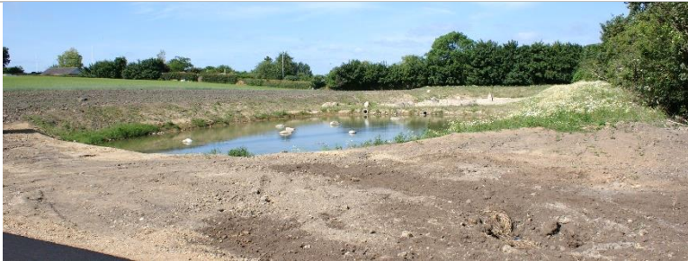
Eksisterende regnvandsbassin i delområde 3 mod vest med tilledning til eksisterende rende ved Grønlandsvej i Korsør.
