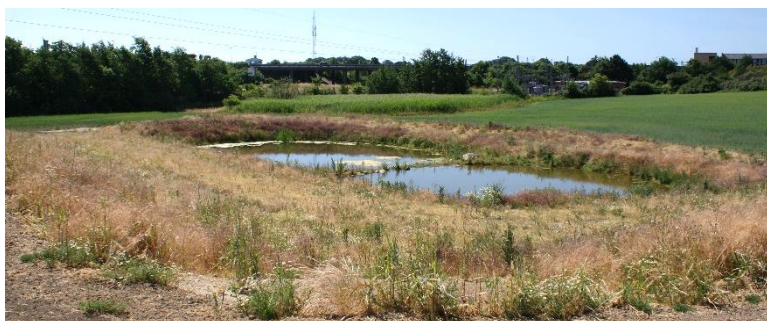
Eksisterende regnvandsbassin i delområde 1 mod øst (det sydlige bassin).
