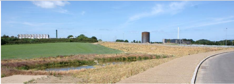
"Kodakhuset" til venstre og varmeværket til højre.
