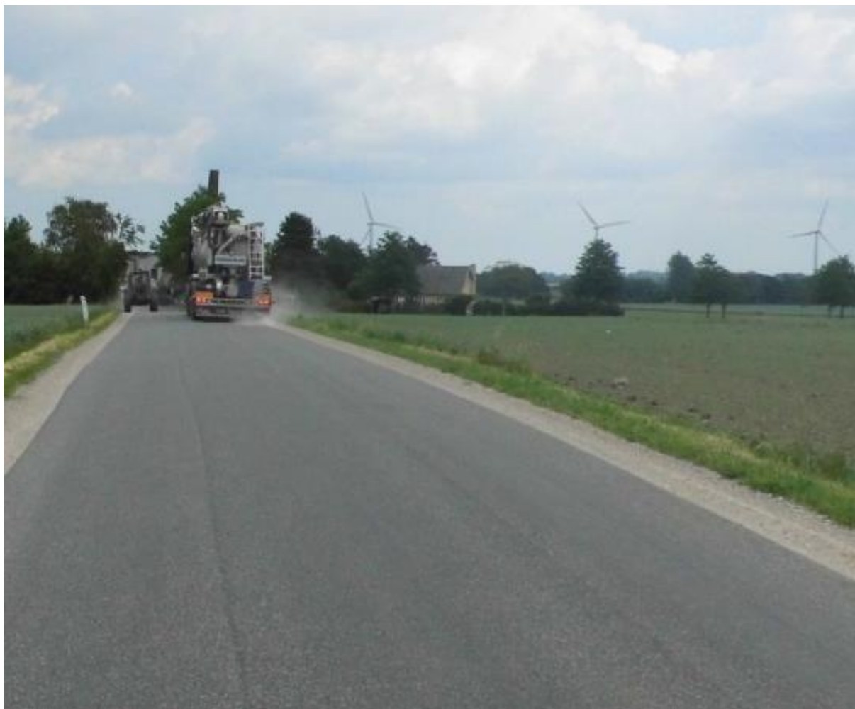
Figur 4.1: Gimlingevej, forbereder passage to større/tunge køretøjer.
