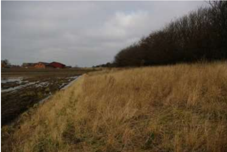
Rensningsanlægget er omgivet af beplantede jordvolde.
