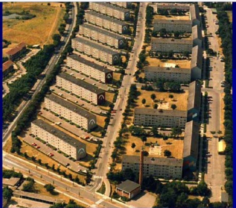
Boligområdet Ringparken beliggende i den nordlige udkant af Slagelse. Består af 732 boliglejemål og 6 erhvervslejemål heraf 2 børneinstitutioner. (Området før renovering)
