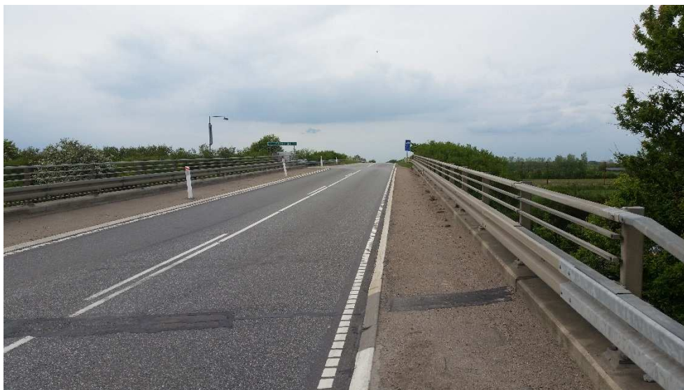
Billede fra tilkørselsrampen mod nord
